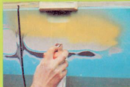
6. Protéger les surfaces voisines. Pulvériser une ou deux couches de primaire garnissant (séchage : 1 heure).
