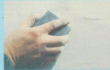
7. Dégrossir le ponçage au papier n° P 80/P 120
