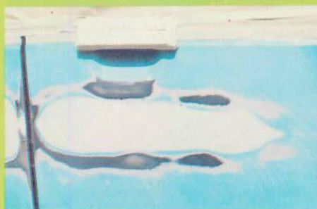
5. Ponçage jusqu'à la mise à nu de la tôle.
