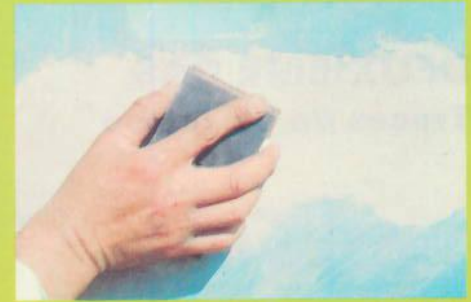
4. Poncer à l'aide d'une cale au papier n° P 80/P 120.
