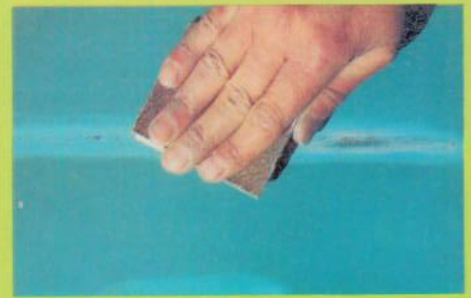
1. Pour les rayures profondes, poncer au papier n° P 80.
