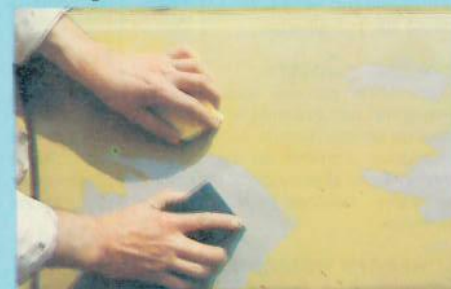
12. Poncer à l'eau au papier n° P 800/P 1.000. Rincer et sécher.
