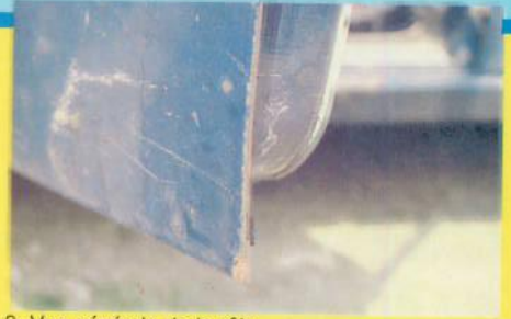
0. Vue générale de la tôle
